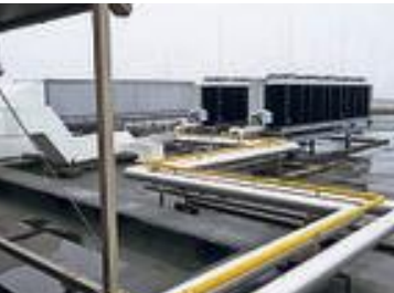
Gaswarmtepompen EIGEN FOTO
